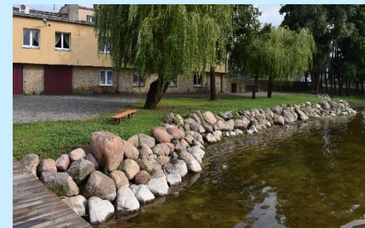
Brenno OSP – widok umocnionego w roku 2018 nabrzeża – miejsca występowania selerów (czerwiec 2019)
